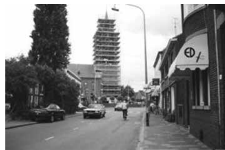
De kerktoren in de steigers gezien vanaf de Amyerstraat Zuid (foto comité torenfonds)
